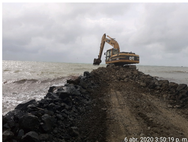
Foto 27. Construcción de la sección del tómbolo # 2
