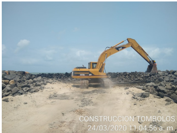
Foto 31. Conformación material escollera del tómbolo # 2.
