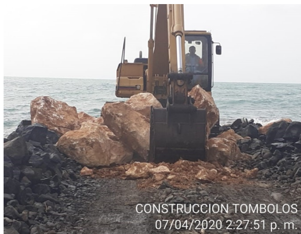
Foto 28. Vista panoramica seccion de la estructura del tomobolo # 2
