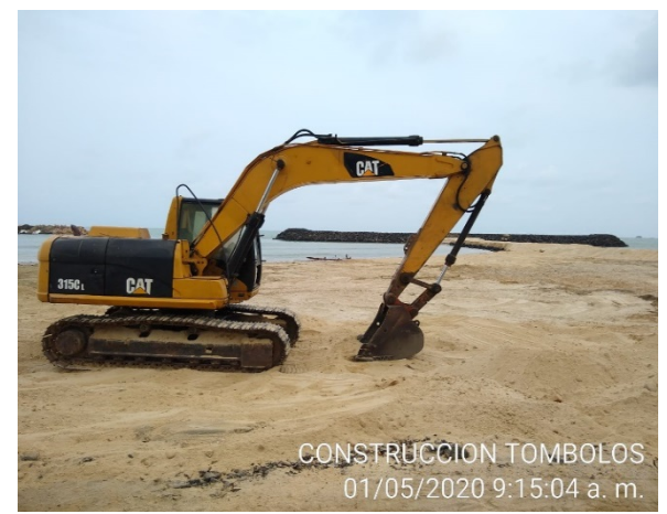
Foto 36. Regada y conformacion arena para regeneracion de la playa
