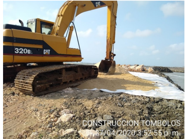
Foto 34. Intalacion geotextil, colocación material de proteccion
