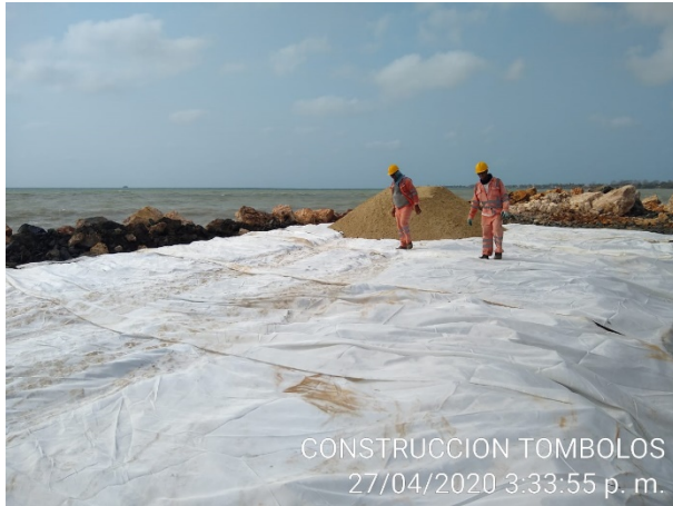
Foto 33. Intalacion geotextil,
