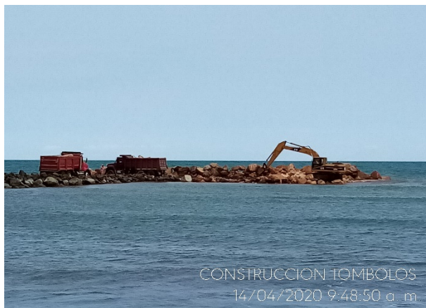
Foto 29. Vista panorámica del descargue de material y construcción en el tómbolo # 2.
