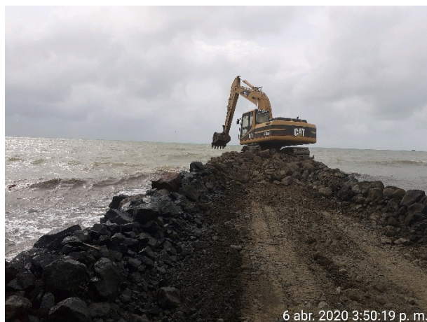
Foto 25. Construcción de la sección del tómbolo # 2
