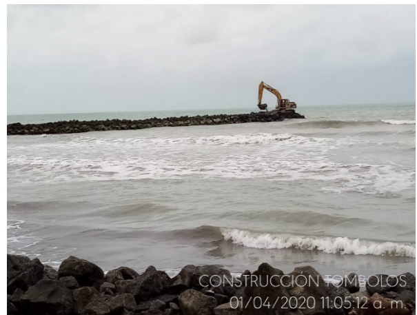
Foto 24. Retroexcavadora colocando escolleras de 250 kg..
