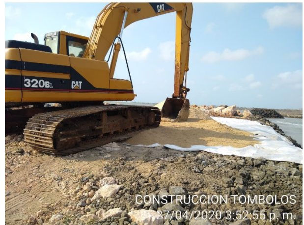
Foto 30. Acopio de material de escolleras proveniente de la cantera la siberia.
