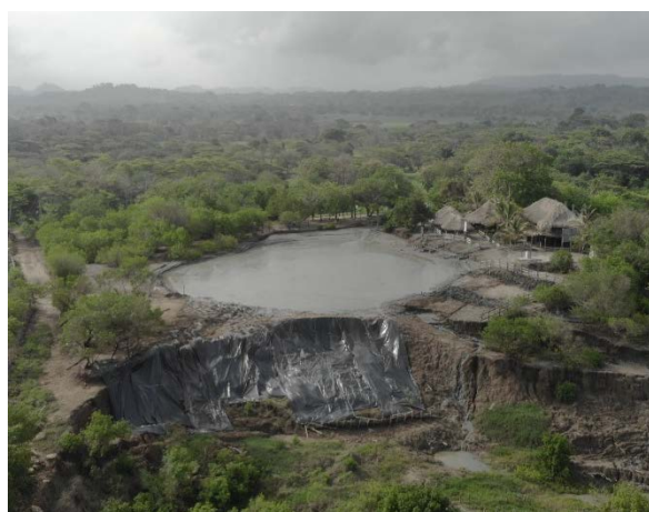
Foto 40. Vista talud d protección con plásticos del talud del volcán erosión cara marina.
