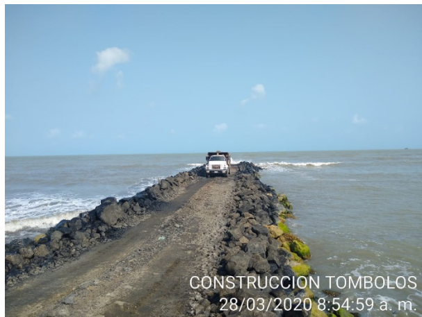
Foto 23. Colocación de ripio de cantera en de vía industrial al tómbolo #
