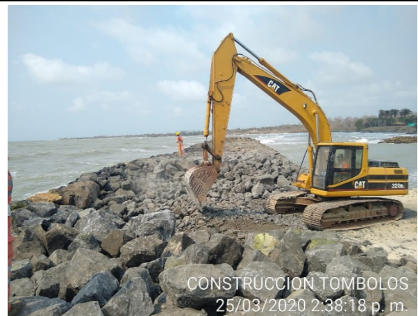
Foto 32. Conformación material escollera del tómbolo.
